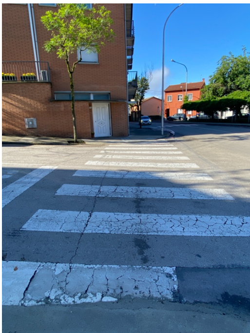
Figura 5.2. Pas de vianants av. Joan de Cabirol-av.Morrot
