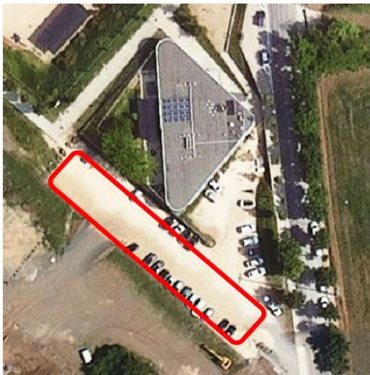
Figura 3.14. Aparcament públic de terra a l'av. Morrot (1)
